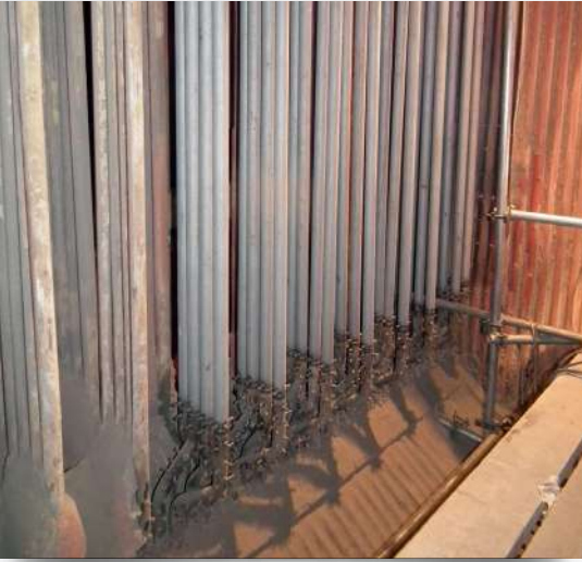
Ön kaplanmış borular kazana monte edilmiş durumda
