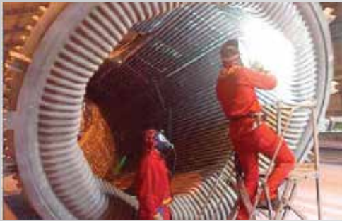
Wassergekühlter Kanal eines Lichtbogenofens
