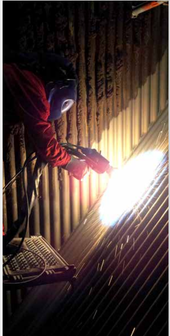
Recargue in situ
